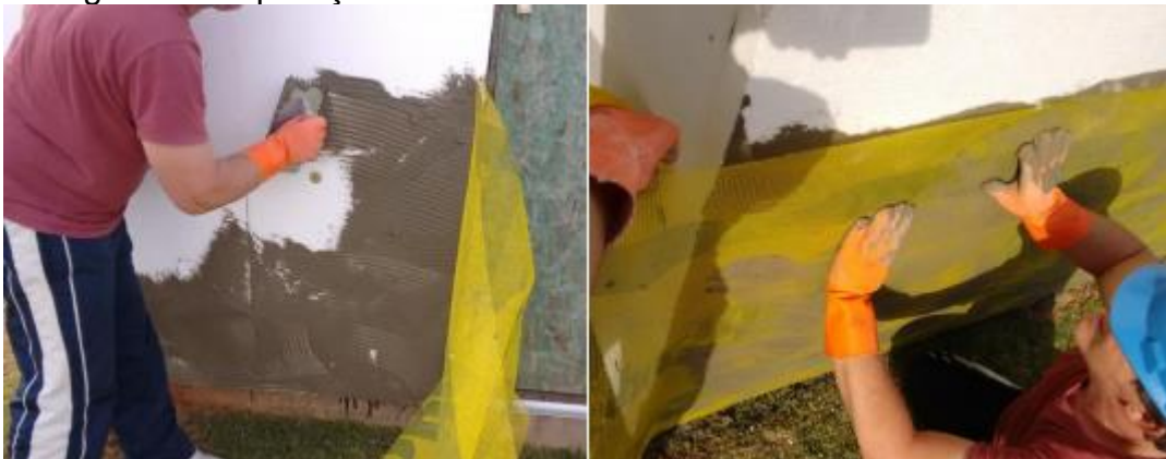
Figura 10 - Aplicação de tela de fibra de vidro e reboco sobre o EPS.
