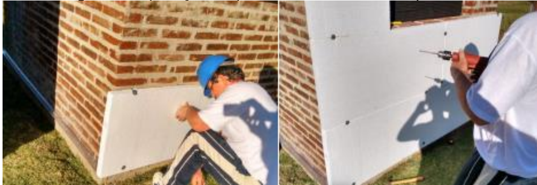
Figura 8 - Aplicação de placas de EPS sobre as paredes.
